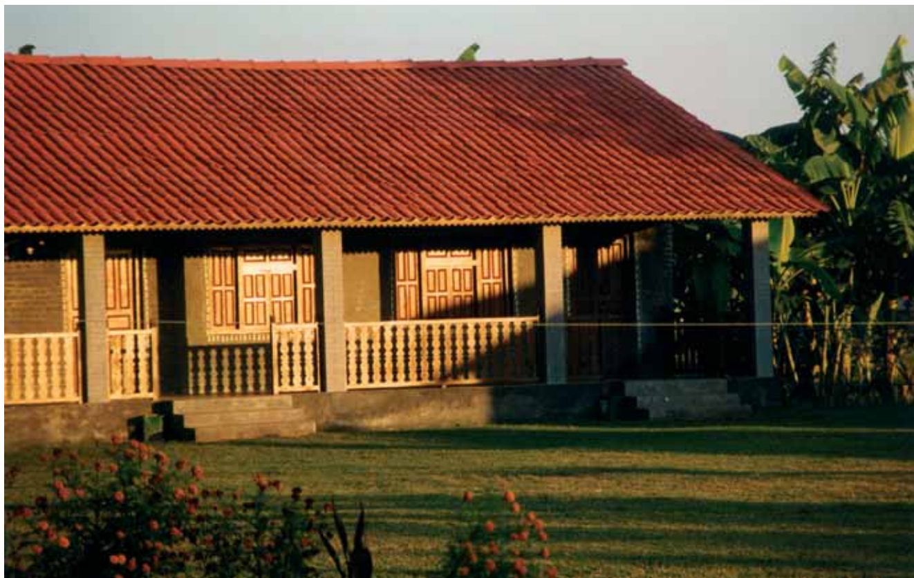
Una escuela en Nepal cubierta con tejas de microconcreto
